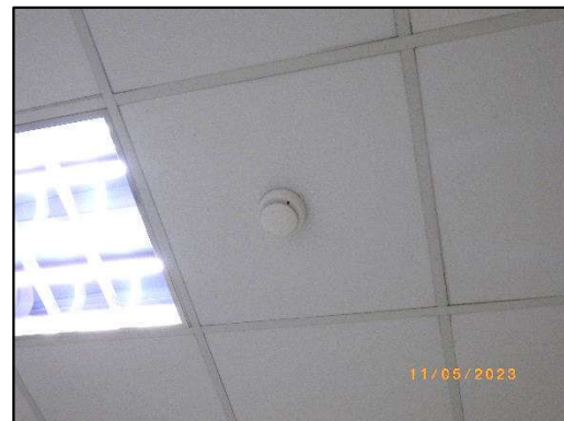
รูปที่ 2-21 อุปกรณ์ตรวจจับควัน (Smoke Detector)
