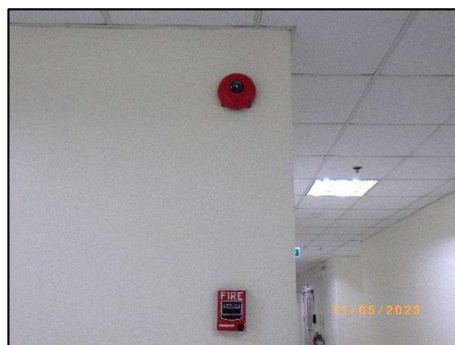
รูปที่ 2-20 การติดตั้งอุปกรณ์แจ้งเหตุฉุกเฉิน (Fire Alarm)
