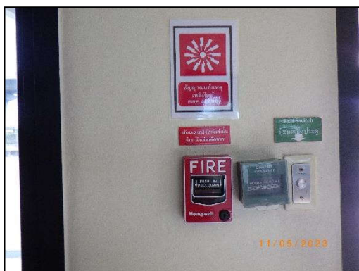
รูปที่ 2-20 การติดตั้งอุปกรณ์แจ้งเหตุฉุกเฉิน (Fire Alarm)
