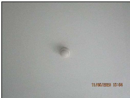
รูปที่ 2-21 อุปกรณ์ตรวจจับควัน (Smoke Detector)
